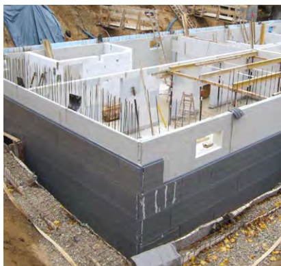
Fig. 03 - Isolamento di pareti controterra
