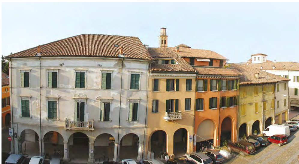
Ristrutturazione di tetti a falde
