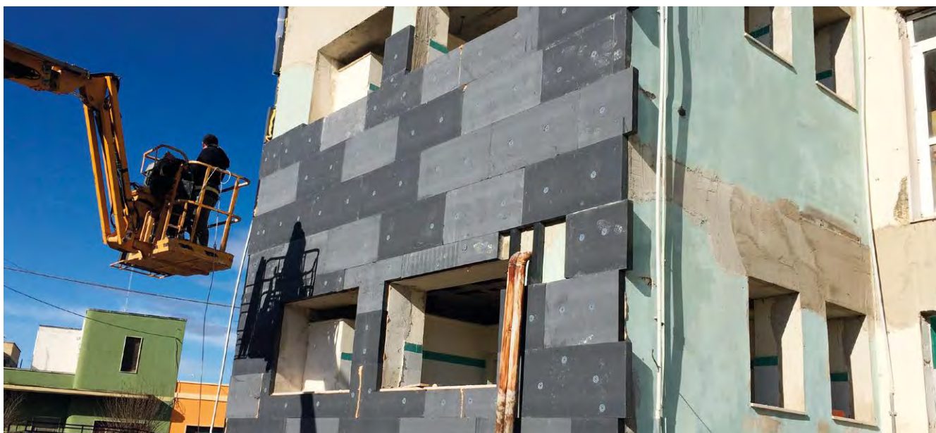
Fig. 05 - Isolamento a cappotto, Scuola di salice salentino
